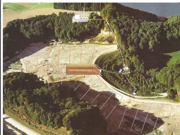
Deponiegasfassung für die energetische Nutzung
