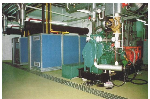
Gasmotor-Wärmepumpenanlage
