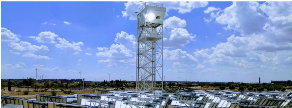
Abbildung 10: Konzentrierende Solaranlage in Madrid zur Entwicklung der Produktion von solarem Synthesegas, aus welchen flüssige Treibstoffe wie Kerosin (über Fischer-Tropsch-Synthese) oder Methanol gewonnen werden kann (Bild: ETH Zurich, PREC).
