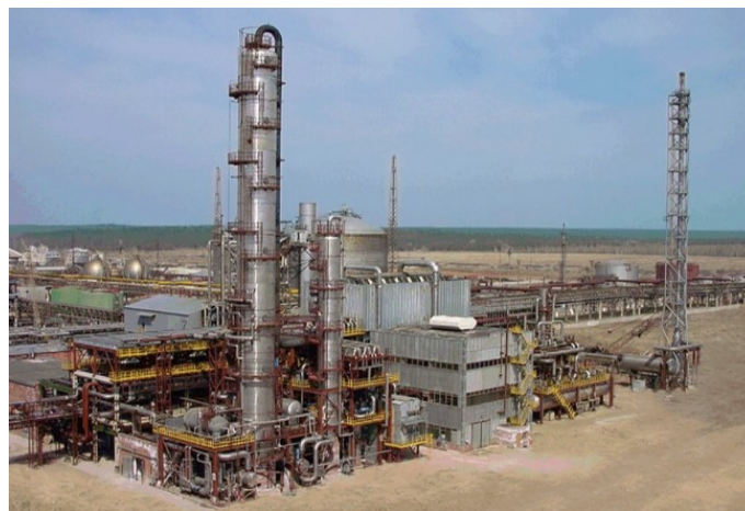
Abbildung 16: Methanolanlage von Casale in Russland mit einer Kapazität von 1650 Tonnen pro Tag (Quelle: Casale SA).
