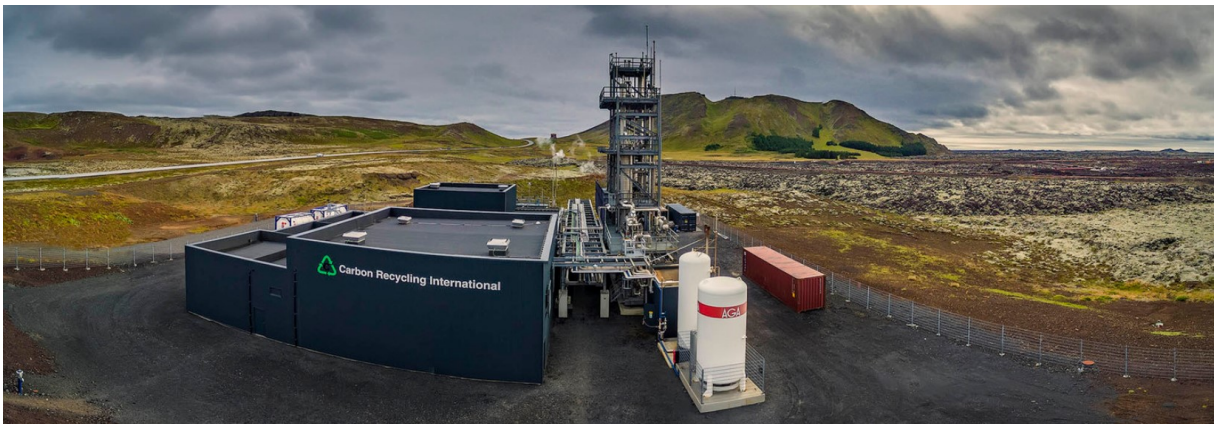
Abbildung 8: Produktionsanlage zur Herstellung von Methanol über Power-to-Liquid-Verfahren der Firma Carbon Recycling International (CRI) in Island, wo Strom für die Wasserstoffproduktion und CO_2 aus einem nahe gelegenen Geothermiekraftwerk genutzt wird (Bild: Carbon Recycling International CRI).
