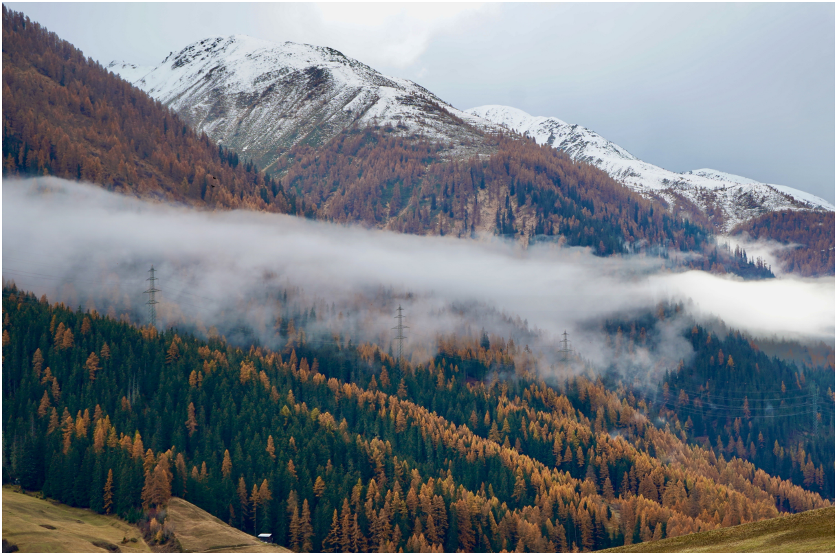
Übertragungsleitung in bewaldetem Gebiet
