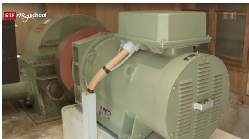
Abbildung 54: Pelton-turbine angetrieben durch Wasser aus dem Pfannibach und Generator mit 32 kW elektrischer Leistung.
