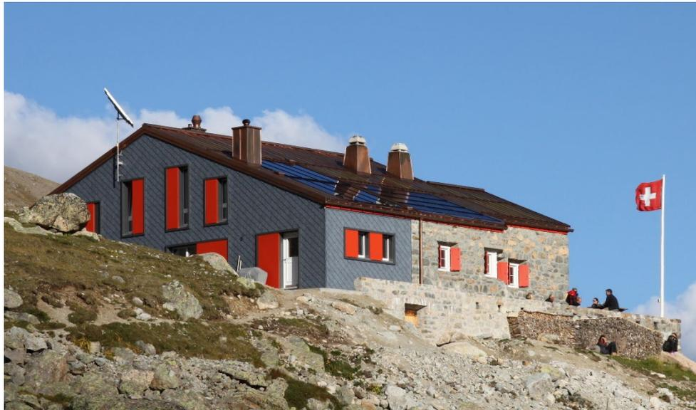
Abbildung 51: Blick von Westen auf die Es-Cha Hütte mit dem neuen Anbau. Zu sehen sind auf dem Dach die integrierte Solarwärmanlage (links) und die integrierte 3,6 kWp PV-Anlage. Ein weiteres PV-Modul mit 0,4 kWp ist auf einer Stange und mit steilem Neigungswinkel montiert. Dieses garantiert die minimal nötigen Stromerträge auch bei schneebedeckter Dachanlage. Bilder: Camille Decrey ([camilledecrey.ch](http://camilledecrey.ch)).
