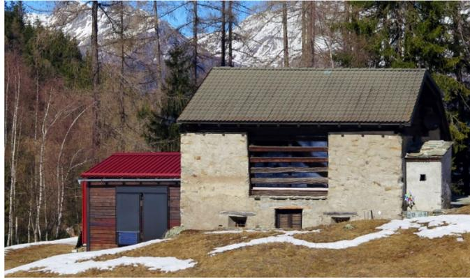
Abbildung 26: Maiensäss mit Solar-Luftkollektoren montiert an der Aussenwand eines Anbaus. Bildquelle: Vassella Energie GmbH
