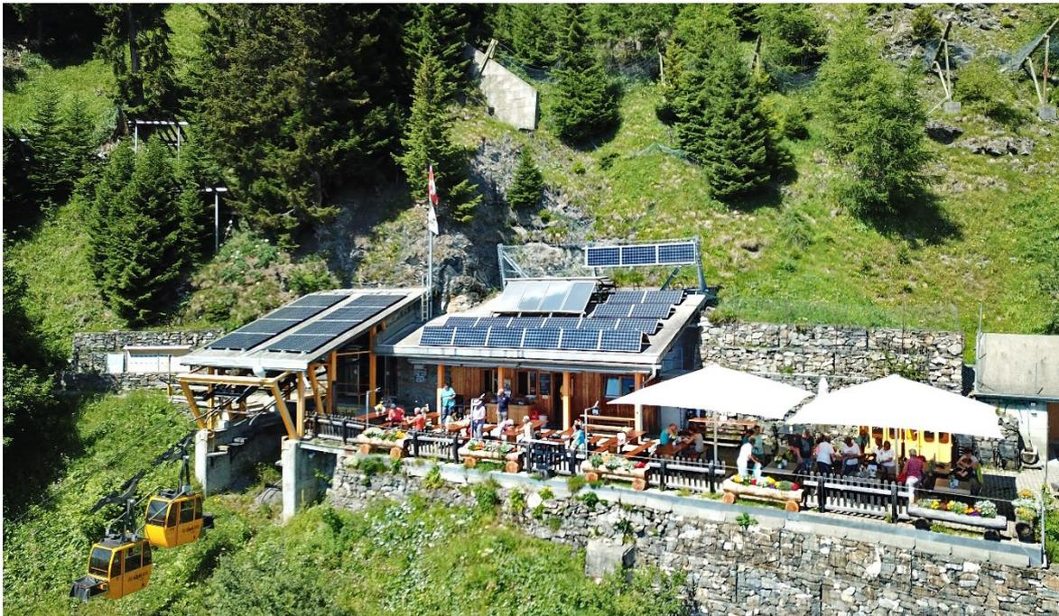
Abbildung 55: Bergrestaurant Älplibahn mit PV-Anlagen auf beide Dächer verteilt, sowie Solarwärmeanlage, steiler aufgeständert auf dem Hauptgebäude. Bildquelle: Franz Egger.
