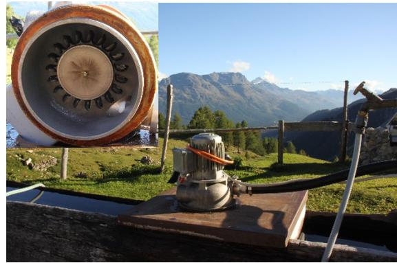
Abbildung 50: Eingang mit PV-Modulen (oben links), Batterie- und Elektrochränke (oben rechts), Peltonturbine mit Generator auf Was-
