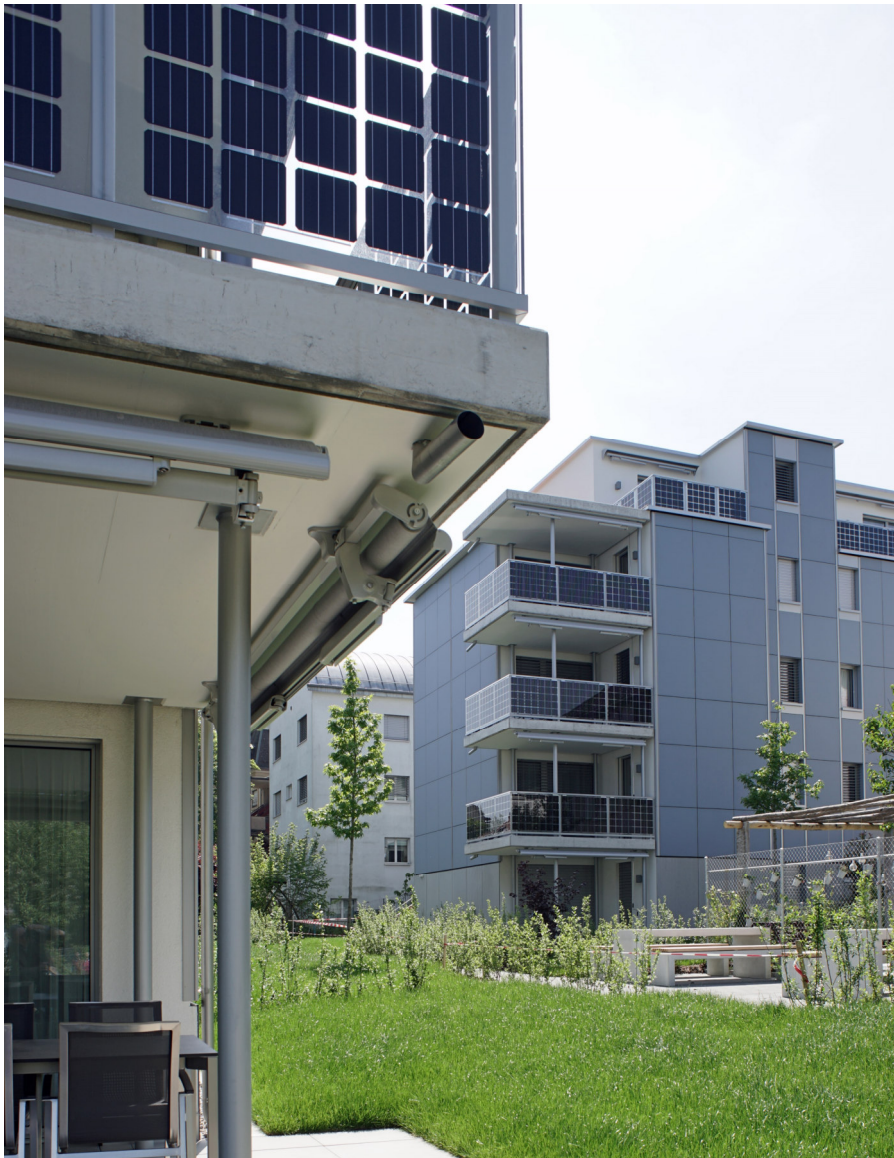
Balkongeländer mit bifazialen Photovoltaikmodulen (Quelle: BKG Architekten)
