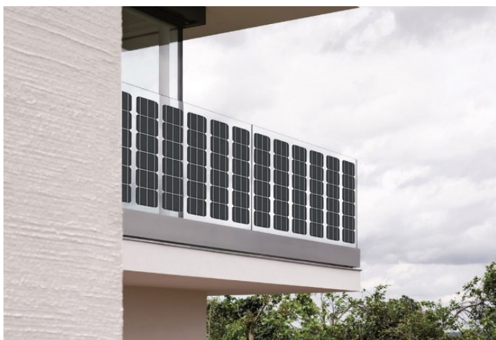
Abbildung 13: Ganzglas-Geländer mit weitestgehend unbeschatteten Zellen: Ideale Einsatzmöglichkeit für bifaziale Zellen (Quelle: https://a2-solar.com/ ).
