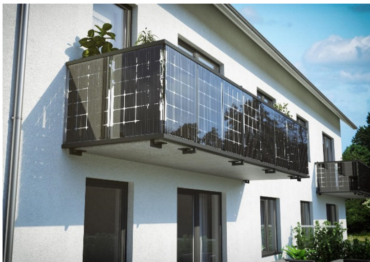
Abbildung 12: Beschattungen auf der Modulrückseite durch die Betonplatte des Balkons und durch die Balkonpflanzen. Der Einsatz von herkömmlichen monofazialen Zellen ist in diesem Fall empfehlenswert (Quelle: www.easycarport.ch ).
