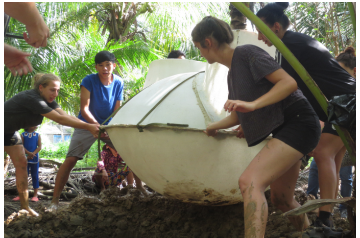
Biogasanlage im Kleinformat: In armen Landstrichen Vietnams werden Fermenter genutzt, um z.B. aus den Exkrementen von Schweinen und anderen Nutztieren Biogas insbesondere für Kochzwecke zu erzeugen. Foto: Nouvelle Planète
