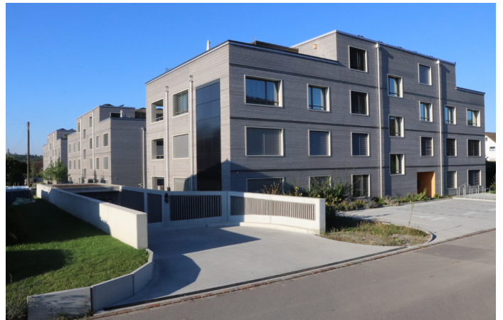
In der Einstellhalle sind bisher zwei Ladestationen für Elektromobile eingerichtet. Angeschlossene Autos werden durch den Eigenverbrauchsmanager bevorzugt mit Solarstrom geladen. Foto: B. Vogel
