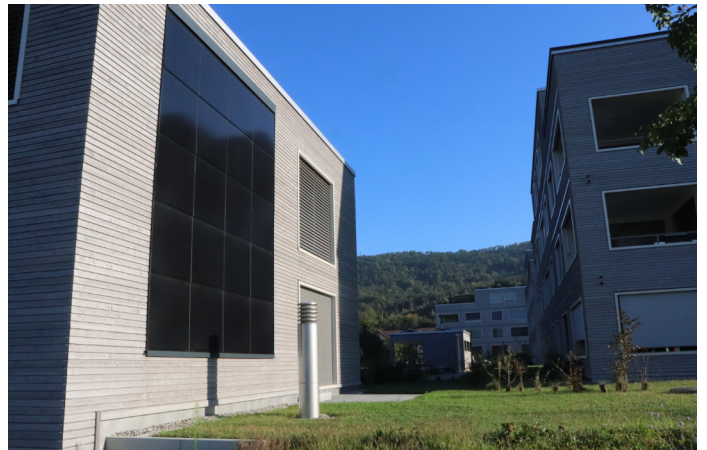
Von der Gesamtleistung der PV-Anlage (164 kWp) sind 120 kWp auf dem Dach und 44 kWp an Brüstungen und Hauswänden installiert. Letztere tragen nach einer groben Schätzung rund 20 % zum Solarertrag bei. Foto: B. Vogel
