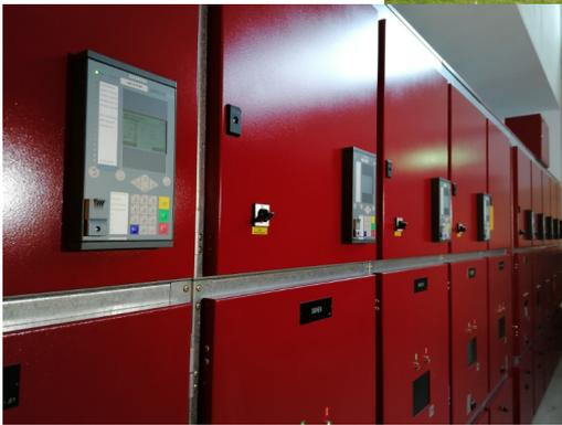
Links: 16 kV-Mittelspannungsanlage im Innern des Unterwerks Hugschwendi mit Schutz- und Steuer-Kombigeräten. Foto: EWO.
