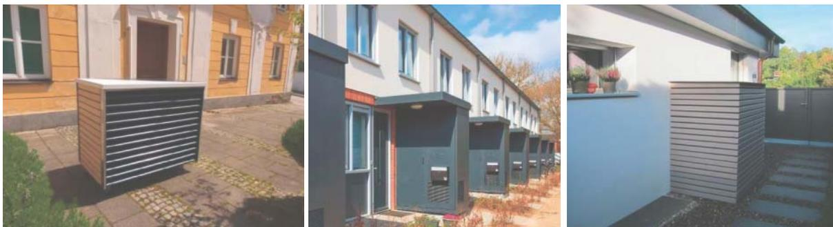
*Bild 7: Verbergen durch Verkleidung. Quelle: Wärmepumpen FFB; Nathan AG; Zaugg AG*
