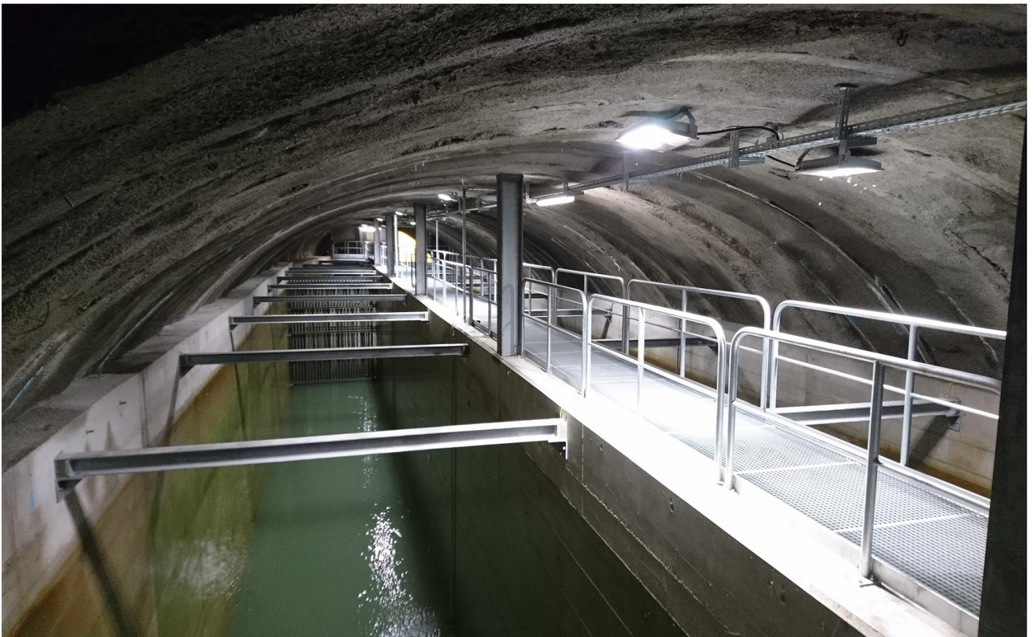
Die Entsanderkaverne des Kleinwasserkraftwerks Gletsch-Oberwald: Das Reservoir wird als Wasserspeicher genutzt; das erlaubt im Kraftwerk eine flexiblere Stromproduktion. Foto: FMV
