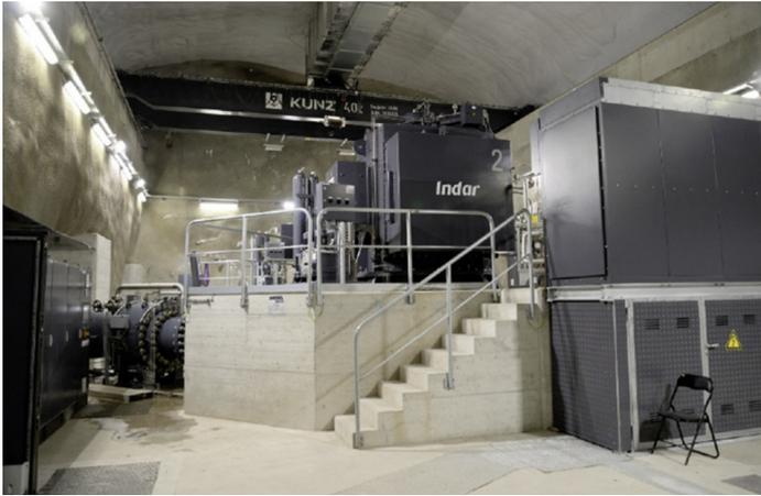
Maschinenraum des Kleinwasserkraftwerks in Oberwald: Die Turbinen mit 2 x 7,5 MW Leistung sind auf die Maximalproduktion im Sommer ausgelegt. Zum Vergleich: Die fünf Windräder, die im Herbst 2020 auf dem Gotthard in Betrieb genommen wurden, haben eine Nennleistung von 5 x 2,35 MW. Foto: FMV
