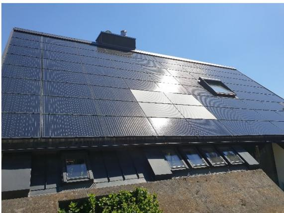
Abbildung 9: Bemusterung mit vier blendfreien Modulen
