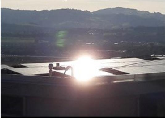
Abbildung 11: Beispiel der Blendwirkung einer PV-Anlage auf einem Flachdach. Die Solarmodule sind in diesem Fall mit leichter Neigung ungefähr nach Osten und Westen ausgerichtet.
