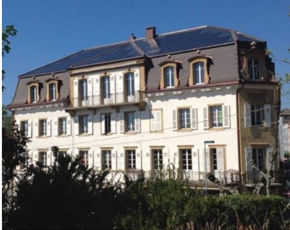
Hôtel des Associations, Neuchâtel, im Quartier du Tertre, ISOS-Inventar mit Erhaltungsziel A. Dachintegrierte Photovoltaikanlage mit 28 kW.
