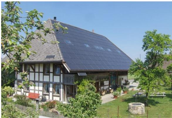
Vollflächig integrierte Photovoltaikanlage auf einem Bauernhaus in Schüpfenried (BE). Damit die Modulfläche das gesamte Dach bedecken kann, wurden in den Randbereichen schräge Blindmodule verwendet.
