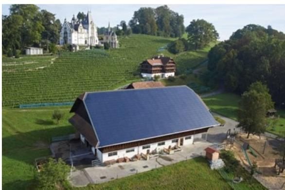
Schlossgut Meggenhorn (ISOS-Inventar mit Erhaltungsziel A), Meggen LU. Scheune mit 100 kW / 580 m<sup>2</sup> Photovoltaikmodulen, vollflächig integriert.
