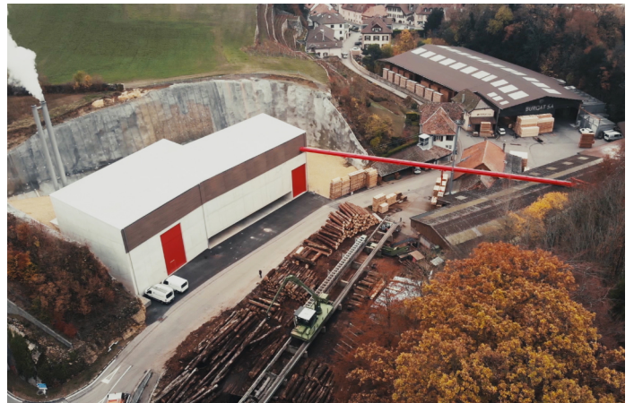
Ein Hängeförderband transportiert die Hackschnitzel vom Sägewerk zum Holzheizwerk (links im Bild). Foto: Viteos
