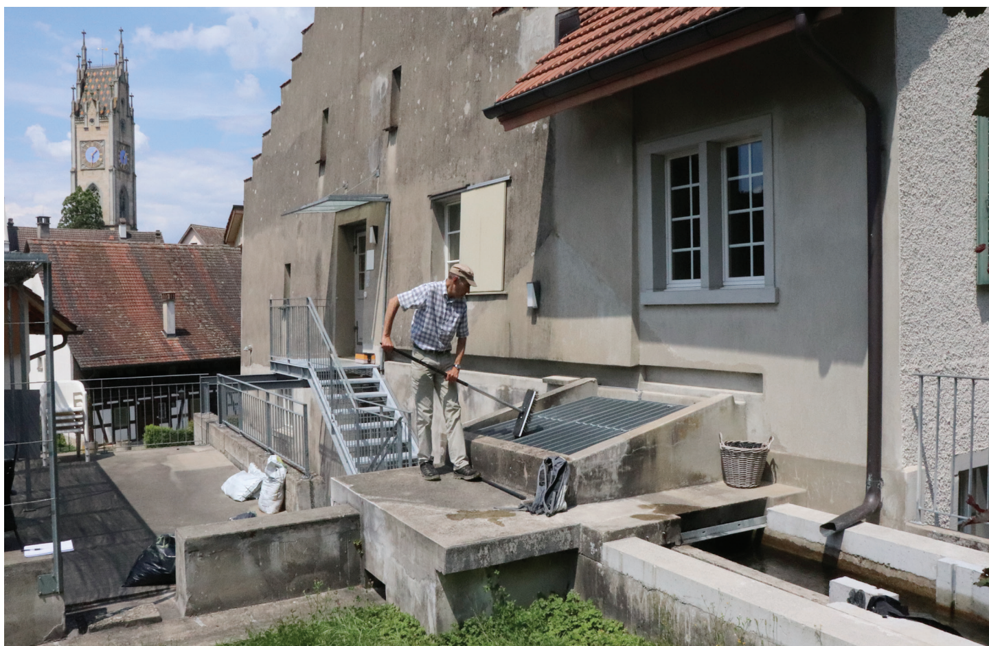
Obermühle in Andelfingen: Der Mülibach (rechts) wird in einem Kleinstwasserkraftwerk zur Stromerzeugung genutzt. Peter Eichenberger reinigt von Zeit zu Zeit den Einlauf. Ein Grobrechen ermöglicht Kleinsäugern wie Mäusen und Igeln den Ausstieg aus dem Kanal, ein Lochblech dient als Fischschutz. Foto: B. Vogel
