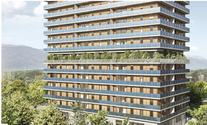
Abbildung 10: Hochhaus C4Tour mit Photovoltaik-Geländer, Meyrin.
