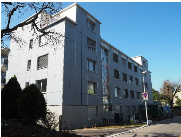
Abbildung 8: Mehrfamilienhäuser, ZH Oerlikon mit vollintegrierten Photovoltaikfassaden. BKG Architekten
