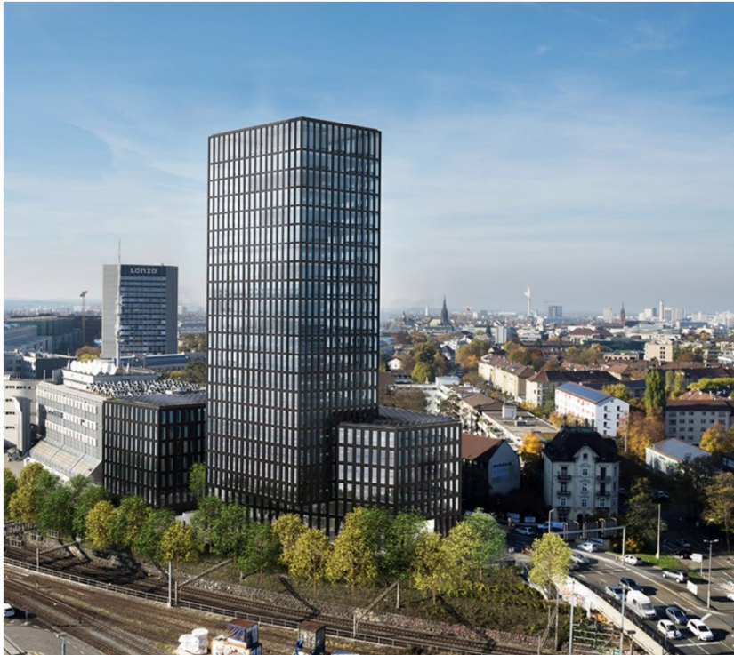
Abbildung 6: Hochhaus-Komplex mit Tower (Büronutzung) und Hotelteil, Basel (Bildquelle: [23])
