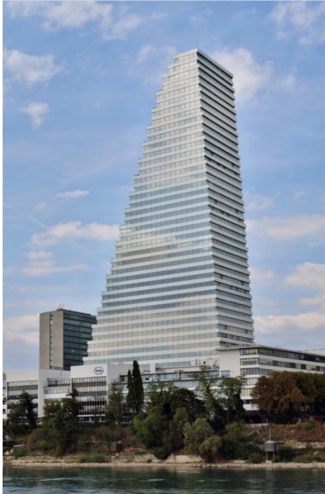
Abbildung 5: Hochhaus, Basel, September 2015 (Bildquelle: [21])
