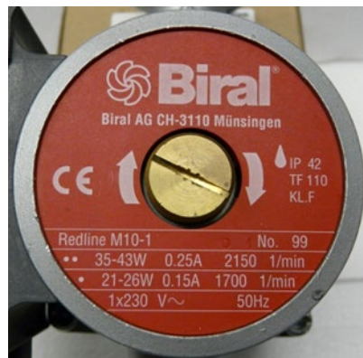
Abbildung 2: Typenschild Pumpe, Quelle: Biral Redline M10-1
