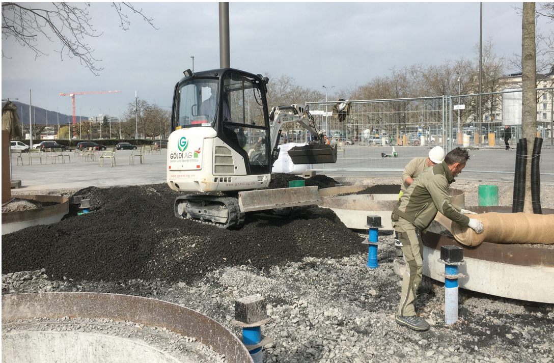
2016 hat das Bundesamt für Landwirtschaft Pflanzenkohle aus naturbelassenem Holz als Bodenverbesserer zugelassen. Pflanzenkohle kommt nicht nur in der Landwirtschaft zum Einsatz, sondern wird unter anderem als Substrat für Stadtbäume eingesetzt (im Bild: Sechseläuten-Platz in Zürich). Foto: Verora
