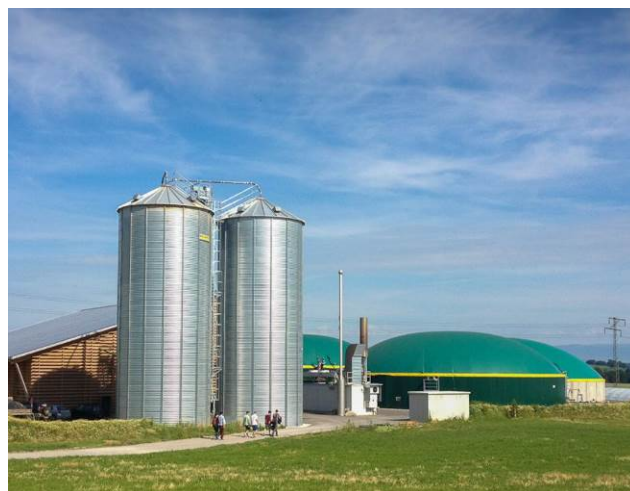
Biogasanlage Düdingen (FR)
