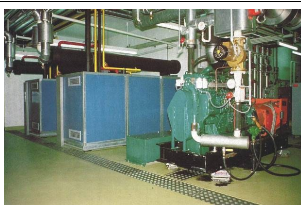
Gasmotor-Wärmepumpenanlage
