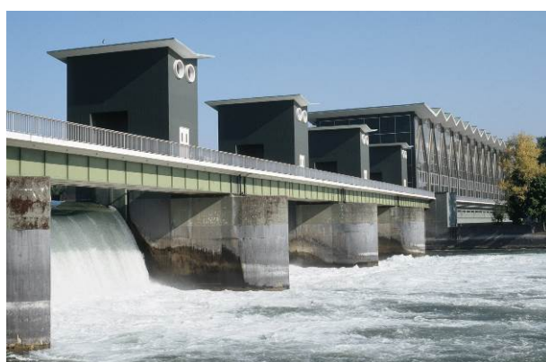
Flusskraftwerk Birsfelden (BL)
