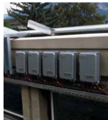
DC/DC-Wandler für einzelne Photovoltaikmodule auf dem Dach der HES-SO Valais Wallis. Jedes der 45 verfügbaren Module ist mit dem DC-Bus über einen eigenen Wandler mit integriertem Maximum Power Point Tracker verbunden. Der Wirkungsgrad der einzelnen Wandler liegt bei 97 bis 98 % (Quelle: HES-SO Valais Wallis).
