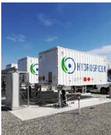
In 2020 geht eine 2MW-Elektrolyseanlage von Hydrospider beim Laufwasserkraftwerk «Gösgen» in Betrieb zur Produktion von «grünem Wasserstoff» für Brennstoffzellen-LKWs. Hier sind Tankcontainern zu sehen, wo produzierter Wasserstoff zwischengelagert wird und der dazu dient, die Tankstellen in der Schweiz mit Wasserstoff zu beliefern (Bildquelle: Hydrospider).
