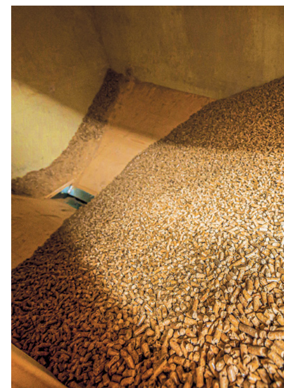
Auch das ist neu: Pelletheizung statt Ölheizung.
