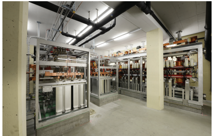
Im Wasserkraftwerk Grimsel 2 sind vier Synchronmaschinen mit 93 MW Leistung im Einsatz. Jede von ihnen kann entweder als Generator (Stromproduktion) oder als Motor (Stromspeicherung) eingesetzt werden. Seit 2013 ist eine der vier Synchronmaschinen mit einem Stromrichter (Foto) ausgerüstet, der es möglich macht, die Synchronmaschine beim Hochpumpen des Wassers in den Stausee im Leistungsbereich 60 bis 100 MW stufenlos zu regulieren. Foto: ABB Schweiz
