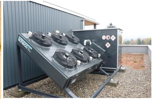
Oben: Die Luft/Wasser-Wärmepumpe (im Hintergrund) mit der Ausseneinheit (Verdampfer/Verflüssiger, je nach Betriebsart) auf dem Dach der 3-Plan Haustechnik AG in Oberwinterthur.
