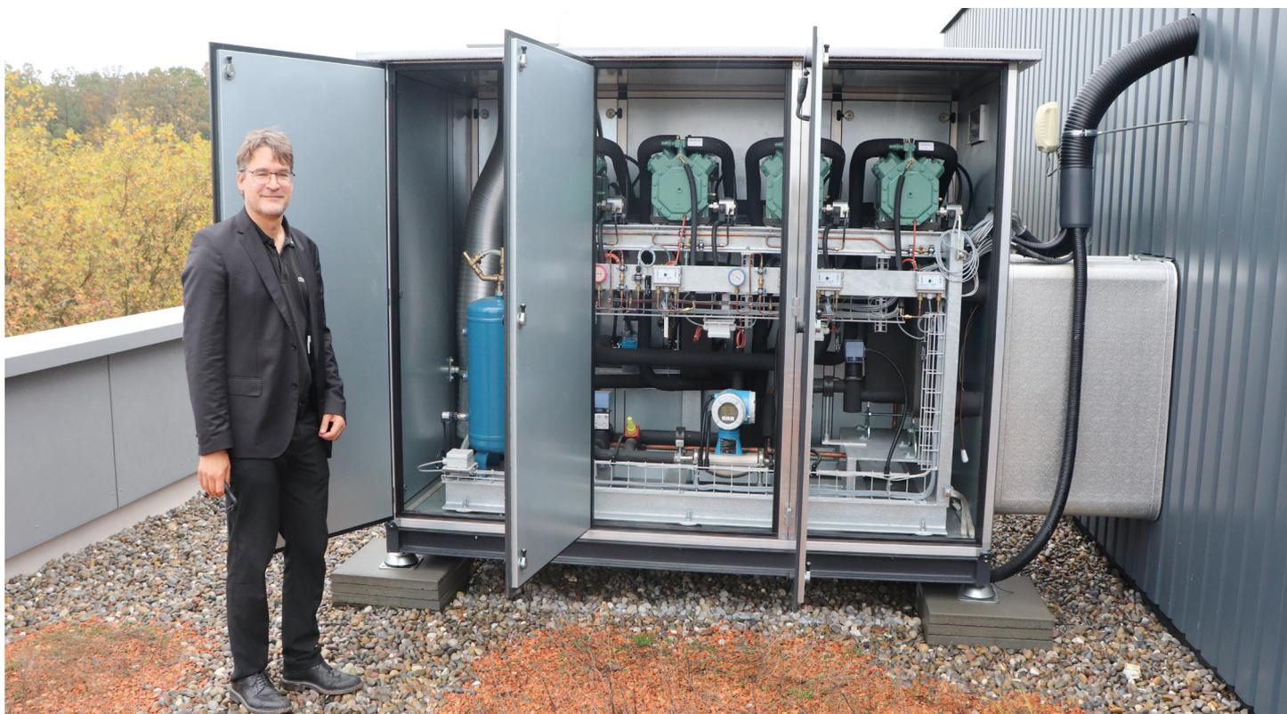
Projektverantwortlicher Stefan van Velsen (3-Plan Haustechnik AG) vor der Luft/Wasserwärmepumpe mit ihren vier Kompressoren. Diese erlauben einen Betrieb im Lastbereich zwischen 15 und 100%. Foto: B. Vogel
