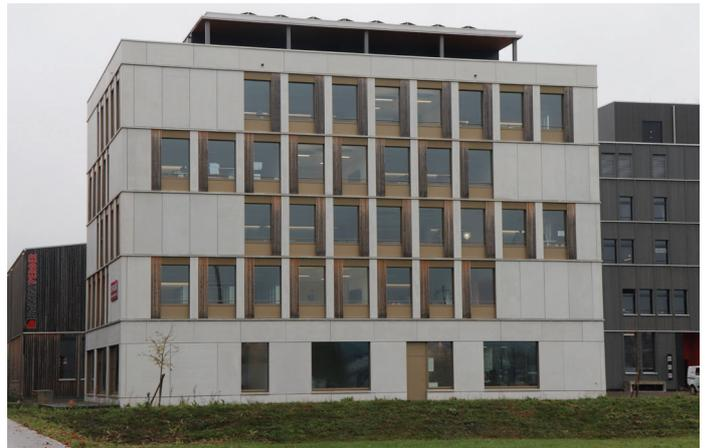
Das Bürogebäude der 3-Plan Haustechnik AG in Oberwinterthur. Die Photovoltaik-Anlage auf dem Dach hat mit 118 m<sup>2</sup> eine relativ kleine Fläche, produziert aber mehr Strom, als das Gebäude zum Heizen, Kühlen und Lüften benötigt. 95% der Stromproduktion werden vor Ort verbraucht. Foto: B. Vogel
