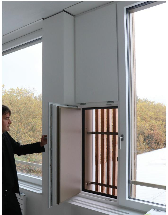
Drei Arten von Öffnungen: Die grossen Fenster bringen Licht und Wärme in die Büroräume, sollen aber nicht geöffnet werden. Ist es den Nutzern zu warm, können sie die Zusatzfenster öffnen (wie im Bild). Über dem Zusatzfenster befindet sich eine dritte Öffnung, die automatisch aufgeht, zum Beispiel zur Nachtauskühlung in den warmen Sommermonaten. Foto: B. Vogel
