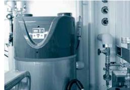
Der Einsatz eines Wärmepumpenboilers kommt nur dann in Frage, wenn dieser in einem unbeheizten Raum installiert werden kann (z.B. im Keller), da er der Umgebungsluft Wärme und Feuchtigkeit entzieht.
