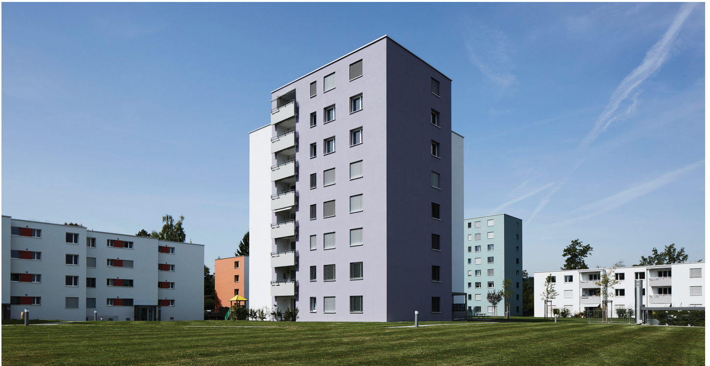
Kürzlich sanierte Liegenschaft aus dem Immobilienportefeuille der Swiss Life in Oberentfelden (ZH). Foto: Swiss Life Asset Managers
